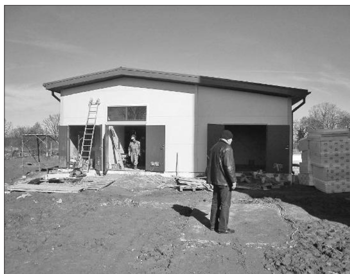
O. Kalpaka ielas dzeramā ūdens atdzelzēšanas stacijas ēkas būvniecība.
