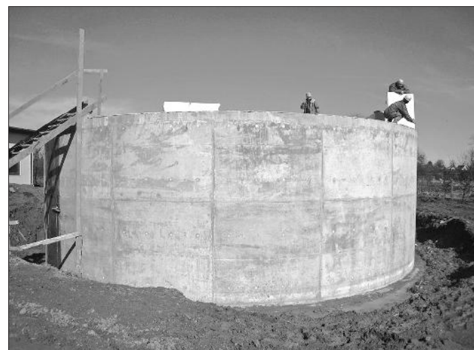
Dzeramā ūdens rezervuāra būvniecība O. Kalpaka ielā.
