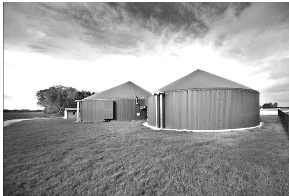
Biogāzes stacijas fermentatori.
