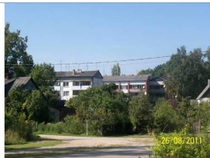
Daudzdzīvokļu ēku apbūve.
